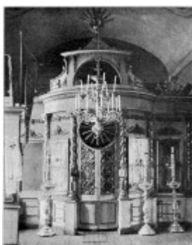
Рис. 14. Внутренний вид церкви в селе Срибитское (1712 г.).
